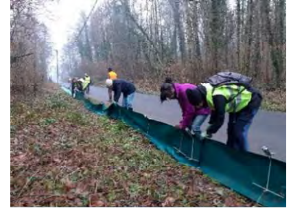
Montage de 400 m de bâche et pose de 30 seaux
