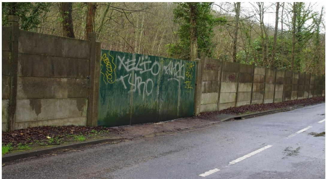
Mur de l'Abbaye du Val Ru du Moutiers Porte de l'Abbaye face au Ru
